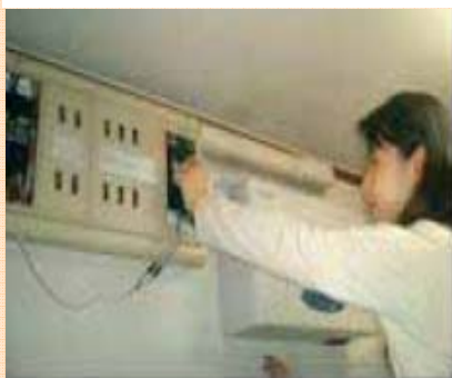
太陽光(連系)ブレーカ OFFを確認
