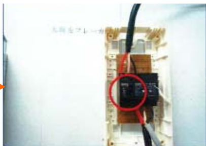
太陽光(連系)ブレーカ OFFを確認
